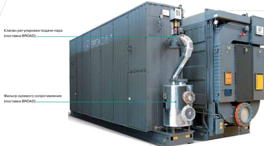
Клапан регулировки подачи пара (поставка BROAD)
